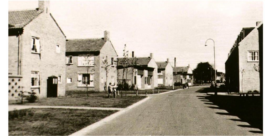
Figuur 2.9: Troelstraan voor herstructurering (Almelo de Kerkelanden, 2014)
